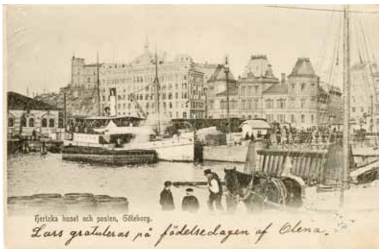
Bild 4. Konsortiets fartyg lade till vid hörnet av den s.k. "Franska tomten", ungefär nedanför hästen i bilden. 300 m längre nedströms i Göta älv ligger skeppsbron med ångslupsbolagets fartyg. I bakgrunden ses Posthuset i Göteborg (huset med tre torn). Foto från början av 1900-talet. Fotograf okänd.
